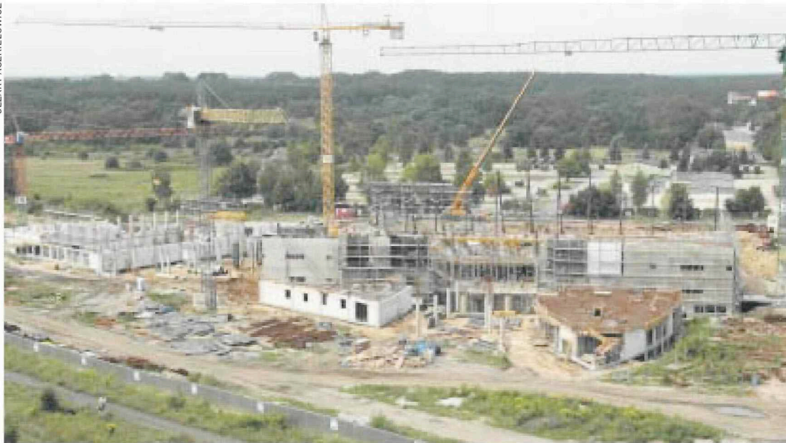
Budowa hali widowiskowo-sportowej w Szczecinie
